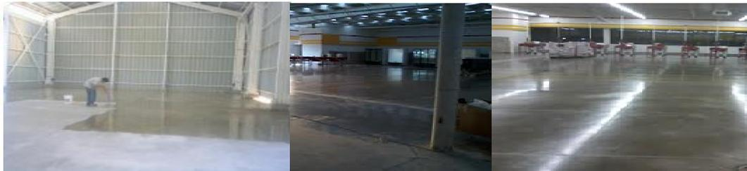
R: El objetivo es abrir el poro del sustrato para asegurar el correcto anclaje del sellador y evitar desprendimientos. Si este procedimiento no se realiza o se realiza de manera deficiente, cualquier sellador sin importar su calidad, se desprenderá todo o parcialmente.
